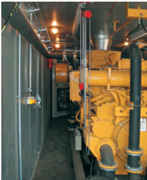
лей, для чего возле каждого из них устанавливается теплообменник – утилизатор тепла антифриза (УТА). Для утилизации отработавших газов используются УТГ – утилизаторы тепла выхлопных газов. Теплообменные аппараты каждой установки включены последовательно по нагреваемой воде: первая ступень нагрева осуществляется в УТА, вторая ступень – в УТГ.
