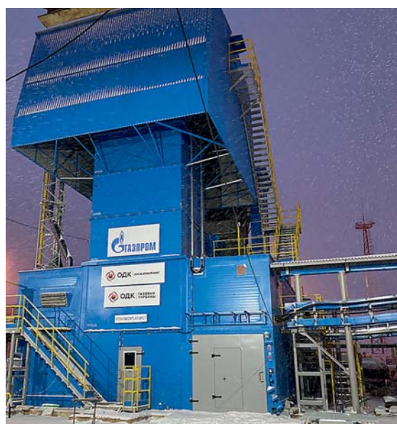
С УГПА-16(25) на КС «Юбилейная». Станция введена в эксплуатацию в декабре 2021 г.
