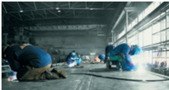
С Начало производства энергомодуля ROLT PS GE 1000 на производстве ЗАО «Ролт Инжиниринг», г. Коломна
