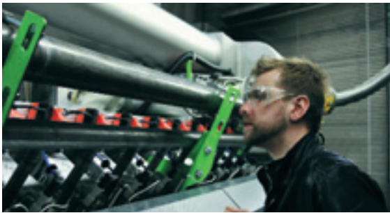
↻ Приемка оборудования на заводе GE Jenbacher в Австрии
