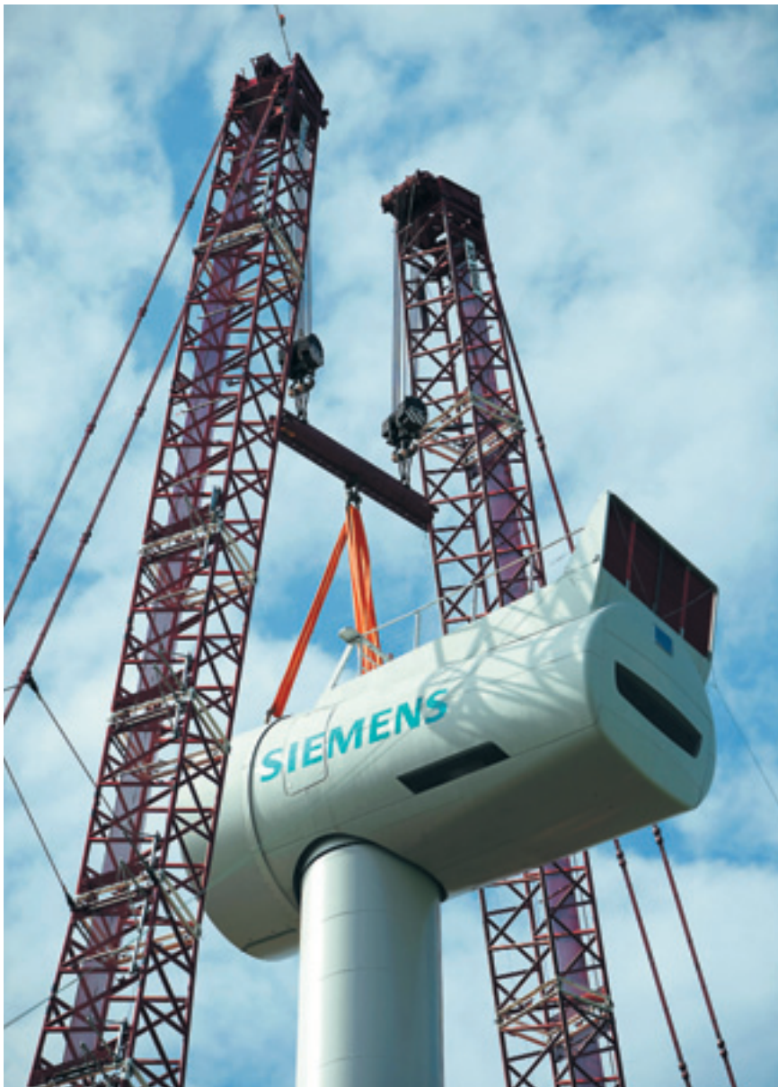
Установка гондолы на башню ветротурбины
