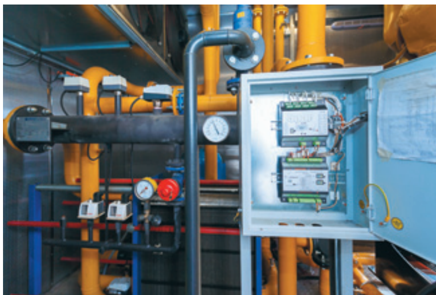
↻ Система управления газоснабжением электростанции
