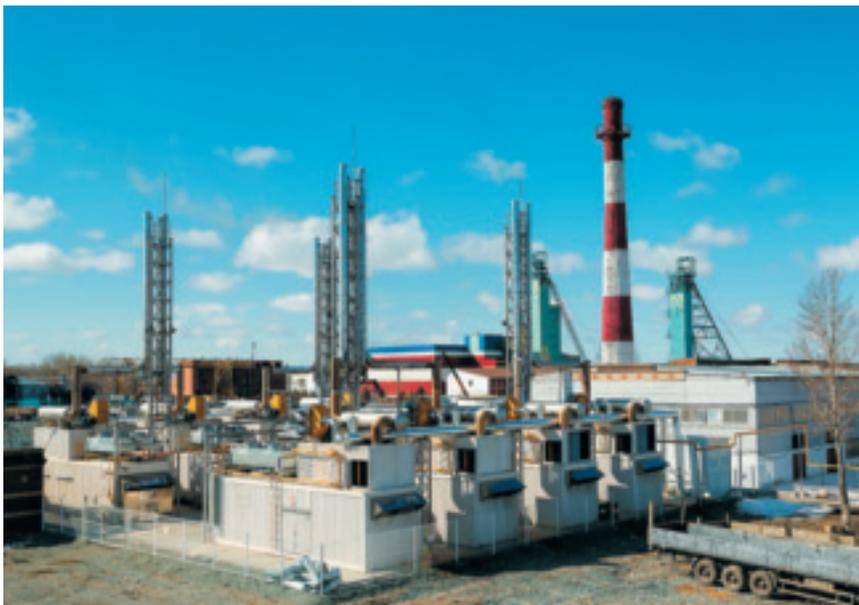
Газопоршневая электростанция обеспечивает электричеством и теплом шахту «Центральная разведочная» («Южуралзолото»), г. Пласт Челябинской обл.
