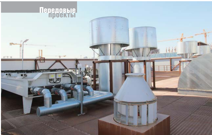
☞ Сухие градирни размещены на крыше ТЭС
