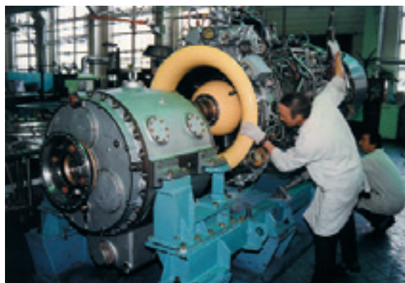
Фото 1. Монтаж газотурбинной установки ГТУ-2,5П
