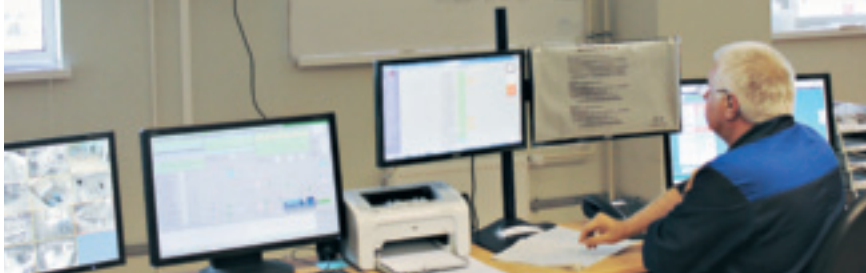
↻ Система управления станцией
