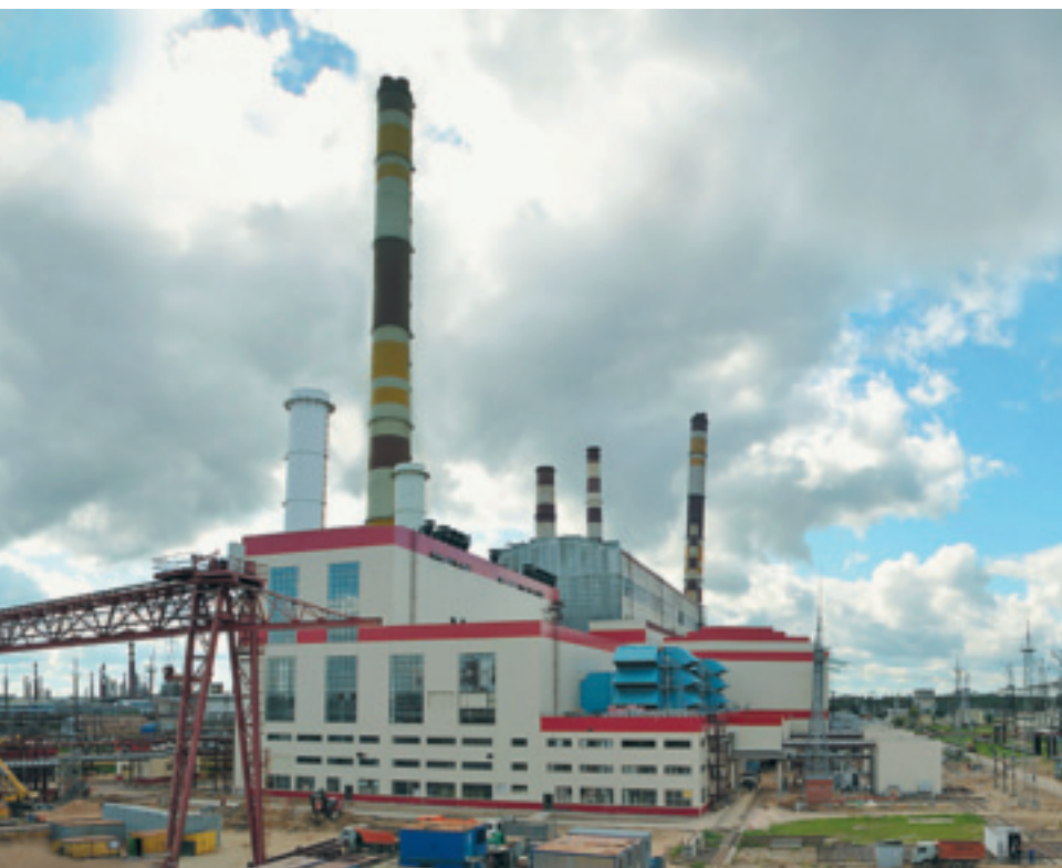
🔧 ПГУ мощностью 800 МВт на базе двух газотурбинных установок SGT5-4000F, Киришская ГРЭС
