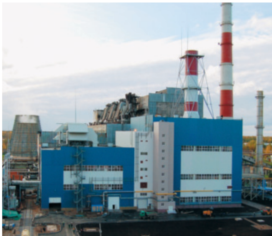
ПГУ-210 на Новгородской ТЭЦ
