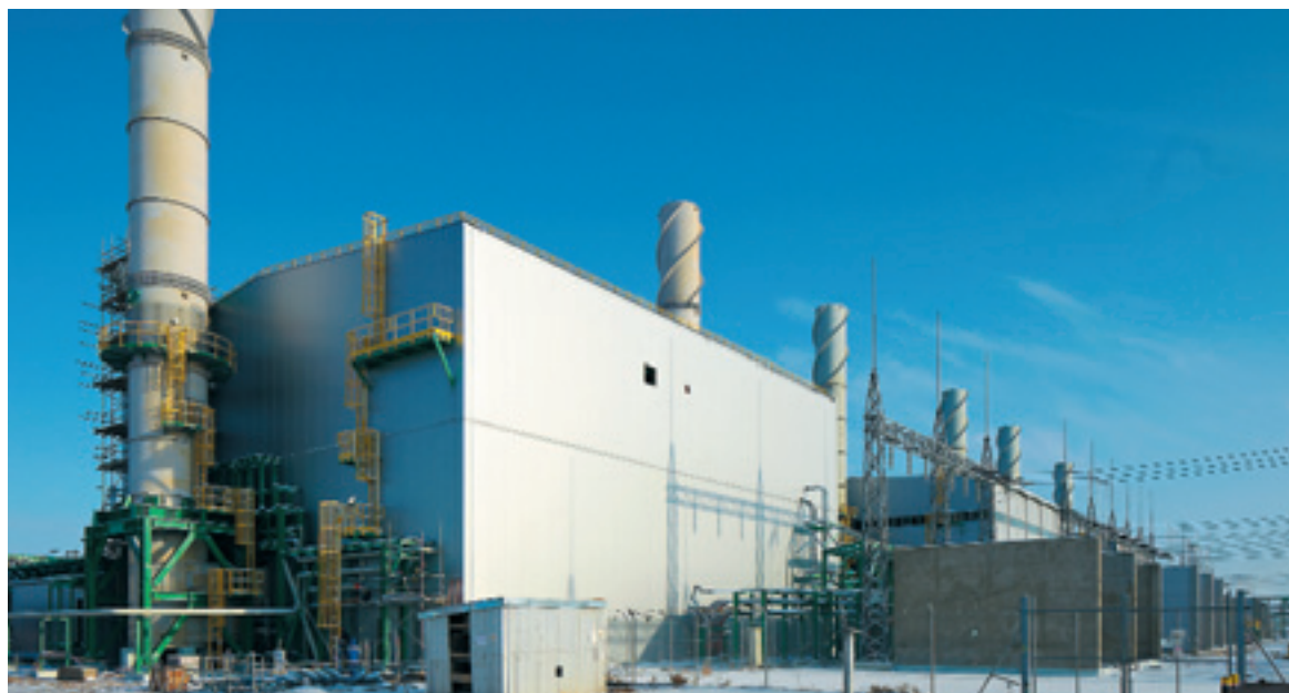
Электростанция парогазового цикла мощностью 238 МВт на месторождении «Кашаган», Казахстан
