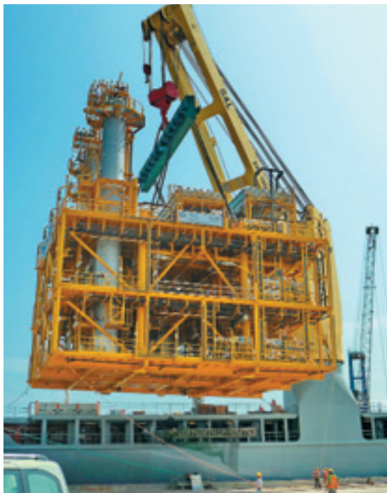
➤ Фото 5. Блок подготовки топливного газа ЭНЕРГАЗ для ПГУ-235, Центральная котельная Астрахани
