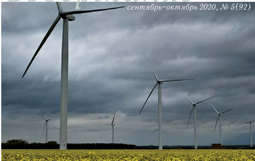
Фото на обложке: ветровая электростанция Langenburg мощностью 40 МВт (земля Баден-Вюртемберг, Германия) на базе 12 энергоблоков V126 производства компании Vestas
