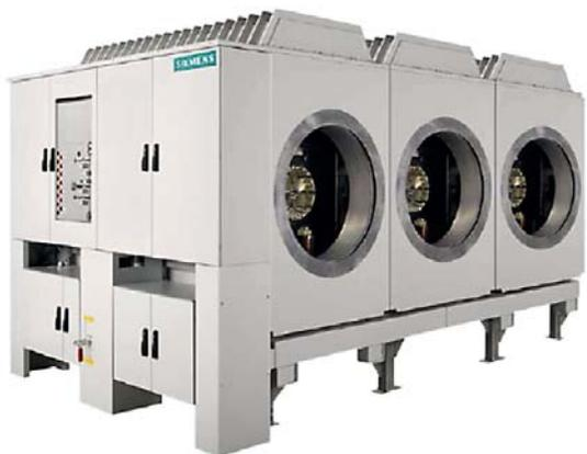
С Фото 5. Генераторное распределительное устройство вакуумного типа HV3-100
