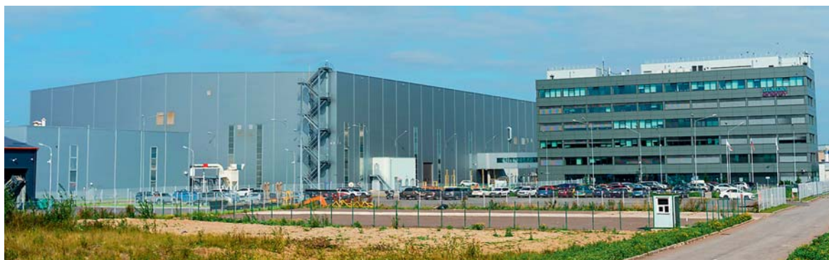
С Многофункциональный энергетический комплекс СТГТ
