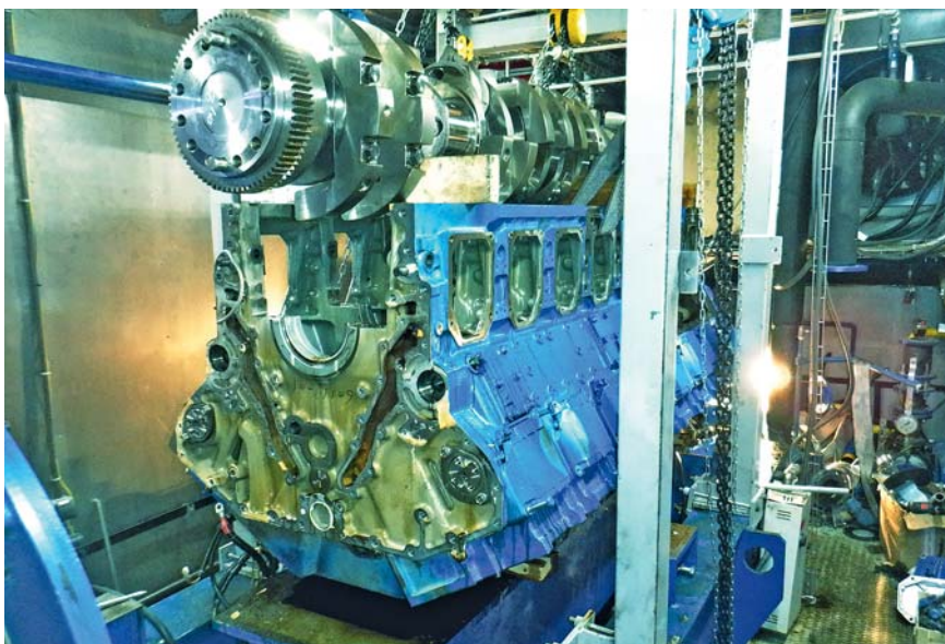
⌚ Капитальный ремонт газопоршневой установки в контейнере
